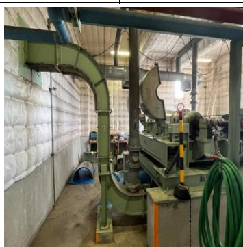
遠心脱水機年次点検設備工事
